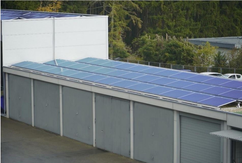
Installation einer PV-Anlage (Garagen und Containerstellplatz)
